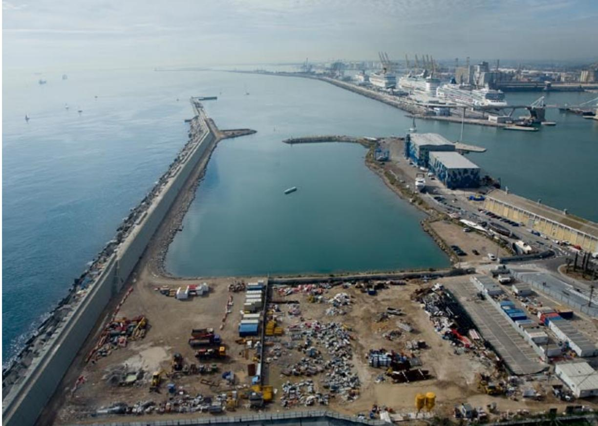
est et 33 mètres contigus à l'alignement nord) ; la réalisation de la superstructure qui comprend une poutre en béton armé de 3,2 m de large sur 2,6 m de haut et porte-à-faux variable et le remplacement des défenses existantes et leur déplacement jusqu'au nouvel alignement, ainsi que le déplacement des bollards.
