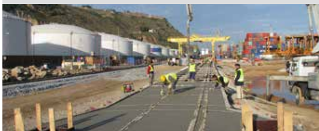
AMPLIACIÓN TERMINAL FERROVIARIA MUELLE SUD. FASE II B
