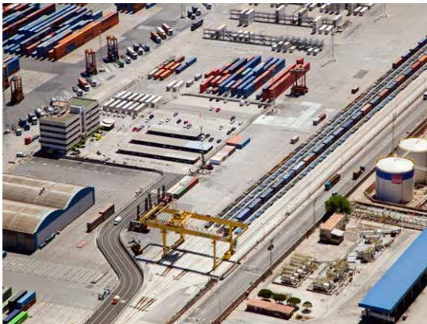
Ce chantier vient achever l'ensemble des travaux prévus dans le terminal ferroviaire du Terminal de Conteneurs de Barcelone (TCB). Le projet définissait l'ensemble des travaux nécessaires à la mise à écartement mixte des voies 1, 2, 3 et 4, à l'achèvement de la mise à écartement mixte de la voie 5 (utilisée
