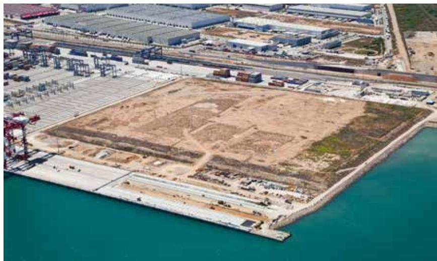
Ce chantier permet d'agrandir la zone de manœuvre du terminal de conteneurs du quai Prat phase 1. Les travaux consistent à achever l'ensemble des interventions prévues dans la zone de manœuvres non concédée du terminal BEST, à l'exception du revêtement des deux rues contiguës au secteur non concédé. Cela permettra d'augmenter la zone de manœuvre du quai de 511 m, qui viendront s'ajouter aux 970 m de ligne d'amarrage exécutés lors de la phase 1.
