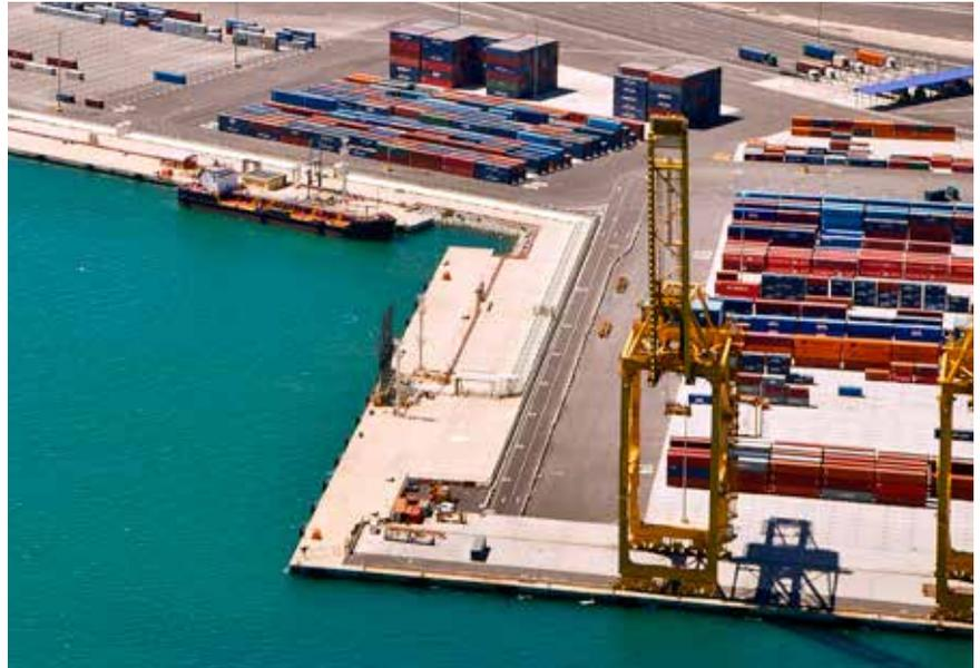
Les travaux nécessaires à l'achèvement de l'extension du quai Sud du Terminal de Conteneurs de Barcelone (TCB) et à son exploitation par l'entreprise ont été réalisés. Le chantier comprenait le prolongement de la voie d'appui du pied de la grue de quai,
