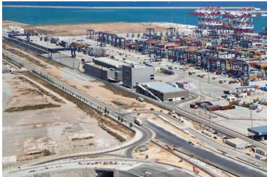
L'objet de ce projet est la création de nouveaux accès à l'extension sud du port de Barcelone. Il s'agit ici de construire le réseau routier du nœud d'accès à l'extension sud. En 2012, la phase 1A avait permis d'exécuter les travaux de terrassement et de remblaiement d'une grande partie de cette desserte, pour ainsi pouvoir entreprendre la
